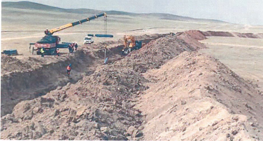
Die Mongolei liegt in einem seismisch sehr aktiven Gebiet, Erdbeben sind häufig. Äußerst wichtig ist daher, dass die Verbindungen der Gussrohre Erschütterungen und Bewegungen aufnehmen können.
