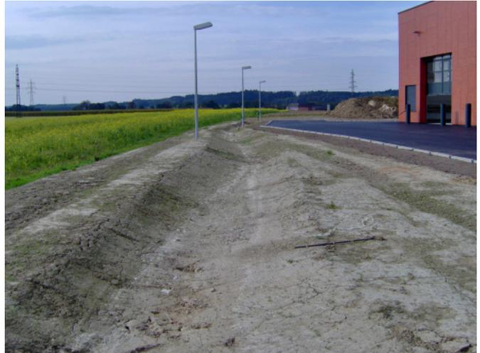
Mulden Element im Bau (schlechte Sickerschicht)
