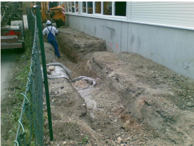
Einbau Rigolkörper in Vlies
