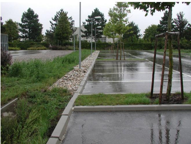
Mulden-Element wurde nachträglich mit Kies zugeschüttet, dadurch ist der Abfluss des Regenwassers nicht mehr gewährleistet. Der Kies musste seitens der Behörde wieder aus den Mulden entfernt werden.
